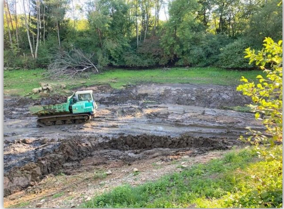
Beräumung durch Bagger – Abfuhr mittels Dumper
