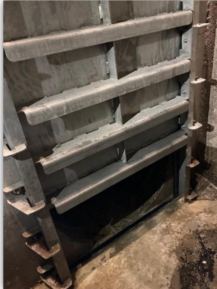
Defekter Grundablasschieber und erneuerter Edelstahl-Schieber
