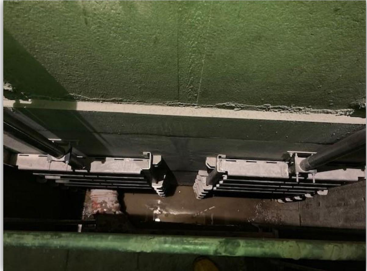
Korrodierte Schieber und sanierte Edelstahlschieber
